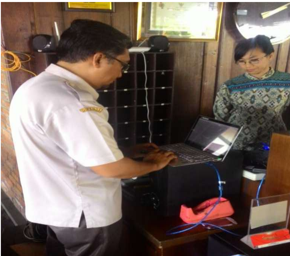
Pemasangan tapping box RM. Waroeng Desa Trawas
