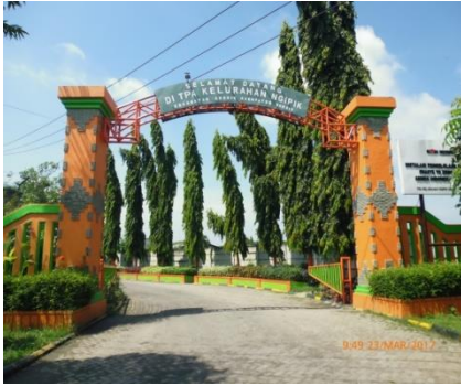
Pintu Masuk TPA
