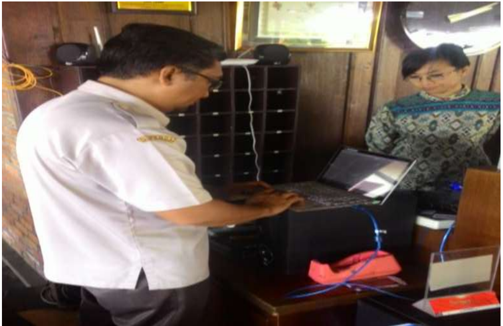
Pemasangan tapping box RM. Waroeng Desa Trawas
