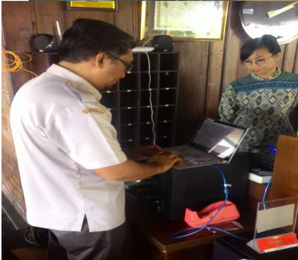
Pemasangan tapping box RM. Waroeng Desa Trawas
